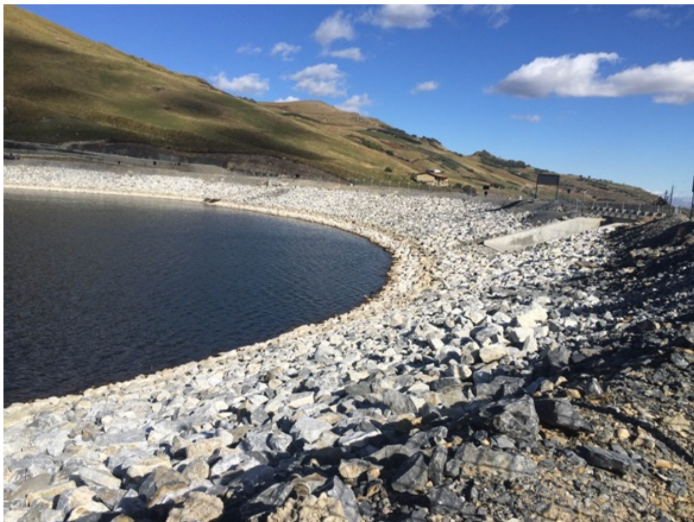
El dique enrocada del reservorio Chailhuagón, sus compuertas permiten que se riegue todo el año en la zona
